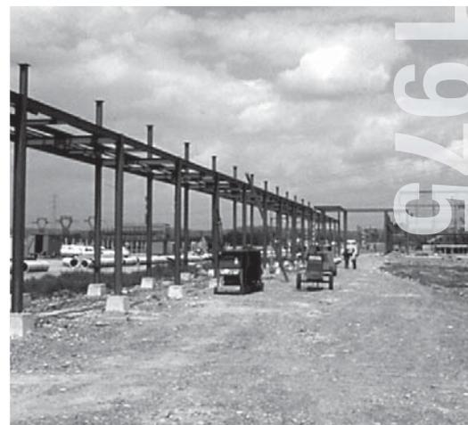
**Construction du rack** destiné à supporter les réseaux qui mailleont la plate-forme entre les Utilités SOBEGI et ses clients (eau, air, condensats, vapeur, eaux industrielles et usagées, eaux biodégradables et solvants).
