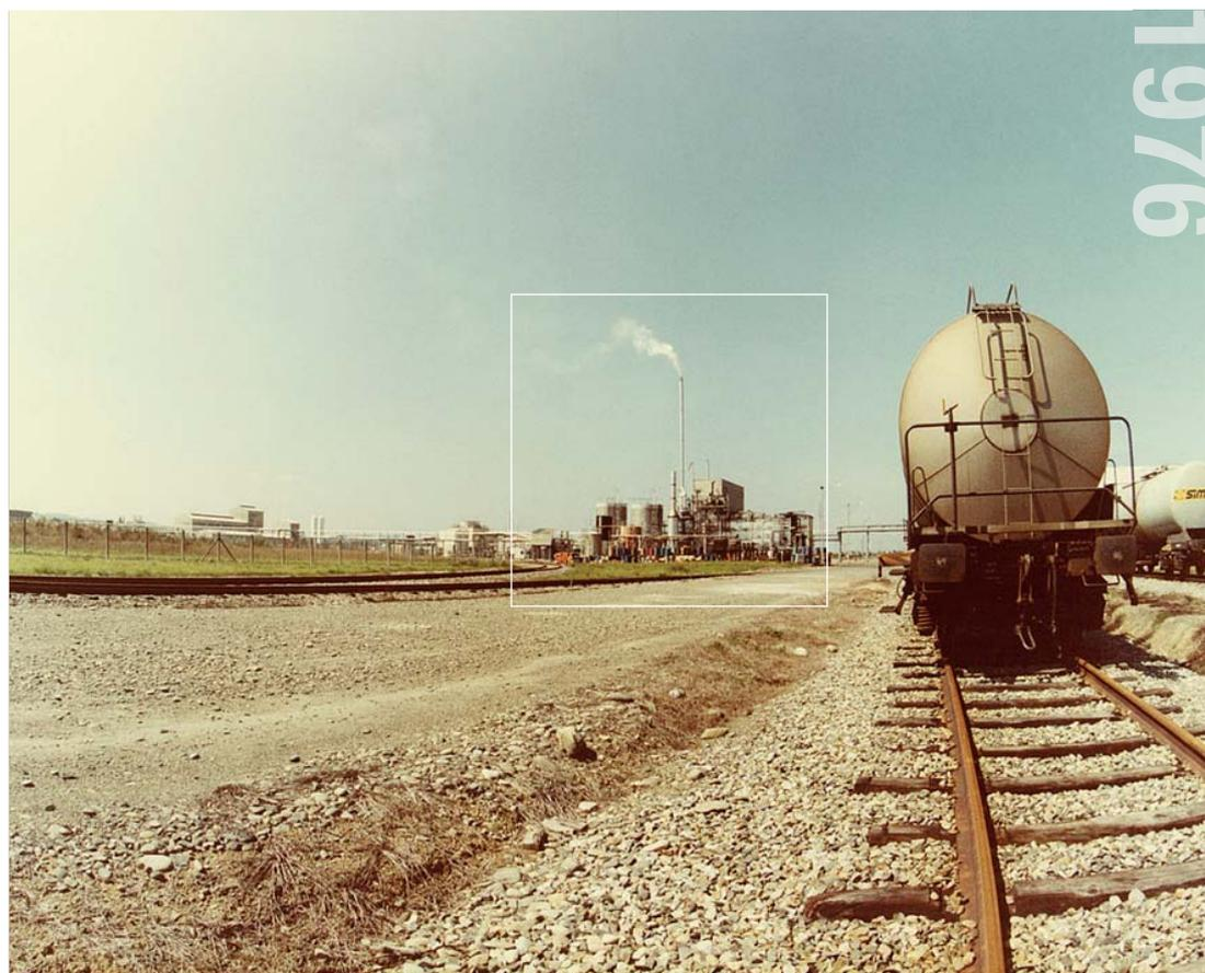
A gauche du wagon, on distingue l'**incinérateur** construit pour brûler les effluents gazeux et liquides des deux premières unités de la plate-forme : PCB et Sapchim-Fournier-Cimag, dont on aperçoit l'unité tout à gauche de la photo (cf. chapitre 2). « Rapidement obsolète, l'incinérateur d'origine a été utilisé un temps comme structure de secours, lorsqu'il a été remplacé ».
